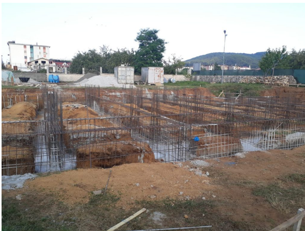
Il cantiere della nova chiesa
